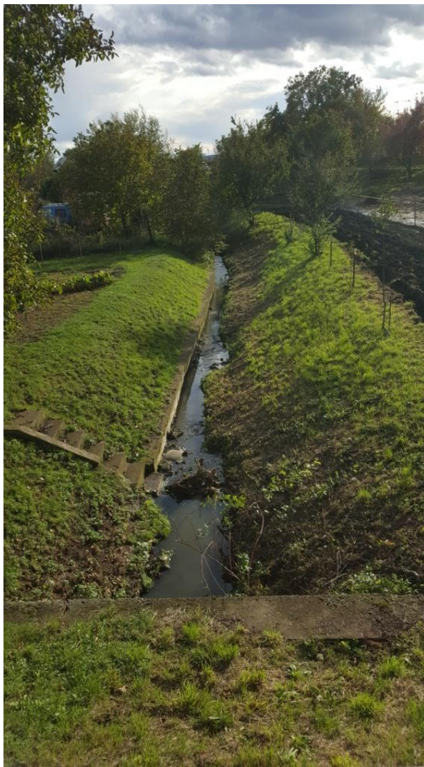
Obr. 9 DUN012 Částečně omezený pohyb koryta betonem a blízké zahrádky (zdroj:autor, 2019)
